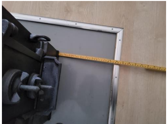
Ildsteder inne i boligen - [Ildsted 2.etasje. ]
