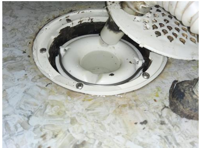
Avløpsrør (ink. sluk) - [Sluk på bad. ]
