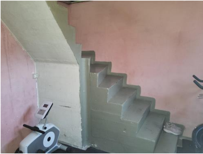
Innvendige trapper - [Trapp til kjeller.]
