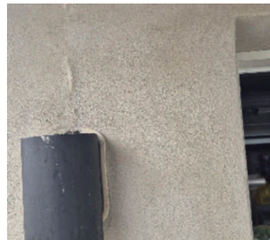
Bilde 1 Utelys ved garasje
