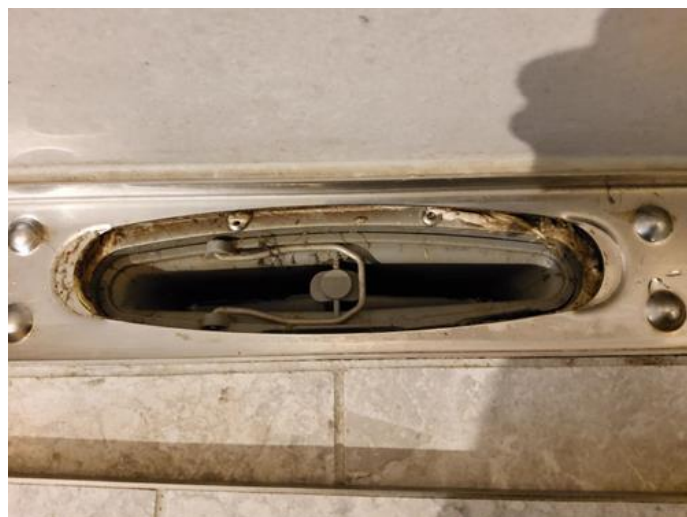
Membran, tettesjikt og overgang til sluk. - [Sluk i bad underetasje.]
