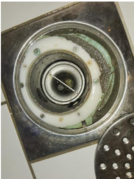
Våtrom - [Sluk bad]
