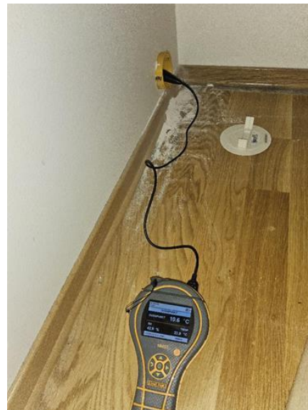
Våtrom - [Fuktmåling fra bod mot dusjsone bad]
