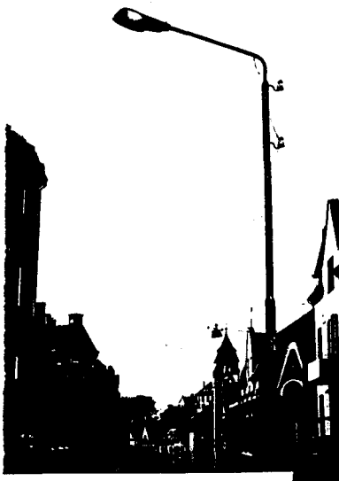
Galgebelysning som bryter gesimslinjen på en uheldig måte.
