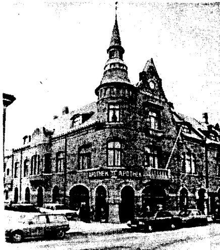
Apotekergata 16. Kanskje byens mest særpregede jugendbygning. Fredet i 1983. Fullstendig restaurert i 1987.
