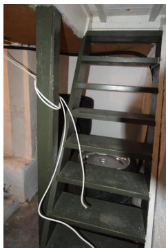
Trapp til loft uten gelender eller hånd-løper.
