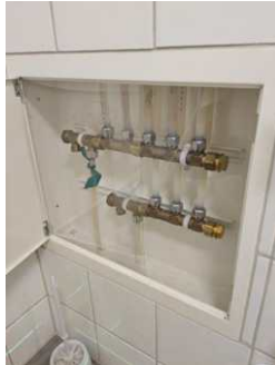
Vannrør - [Fordelerskap for rør-i-rør-systemet]
