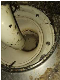
Membran, tettesjikt og overgang til sluk. - [Sluk]
