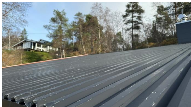
Bilde viser deler av taktekingen.
