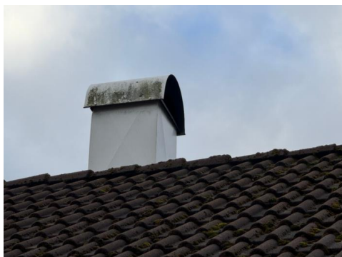
Pipebeslag på pipe.
