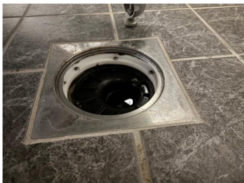
Plastsluk i gulv under badekar.
