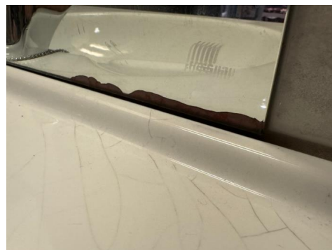
Rustgjennomslag i nedre del av speil.
