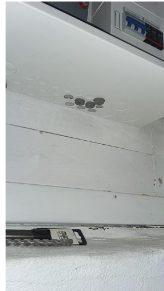
Forenklet vurdering av det elektriske anlegget - [Åpninger i sikringsskap]
