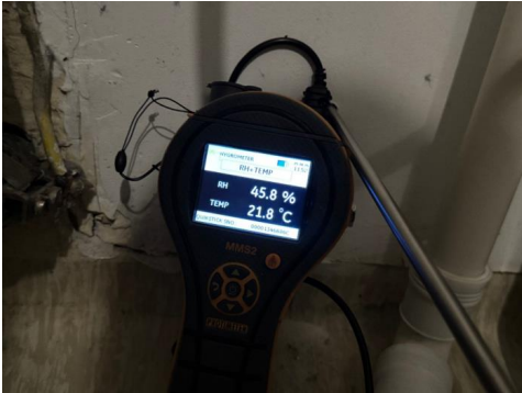
Måling av relativ luftfuktighet.
