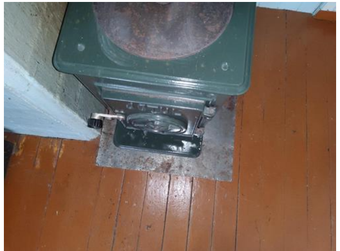
Ildsteder / skorsteiner innvendig. (Omfatter ikke funksjonalitet og innvendig pipeløp) - [Vedovn 2.etasje]
