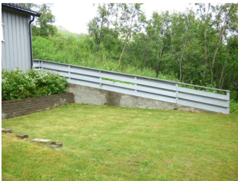
Støttemur mot nabotomt mot nord
