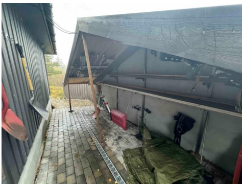
Takutstikk med provisoriske søyler
