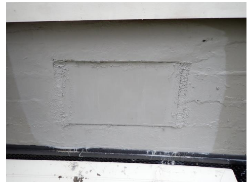
Gammelt vindushull kledd med plater
