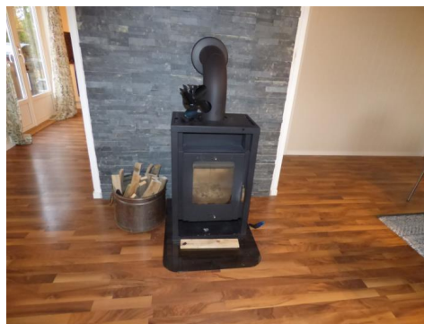
Asgård vedovn, pipe kledd med dekorstein
