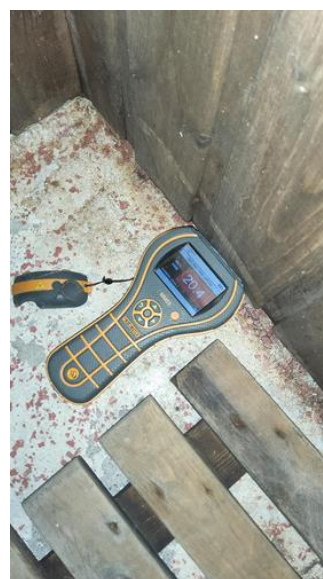
Overflater vegger / himling - [Fuktmåling badstue]
