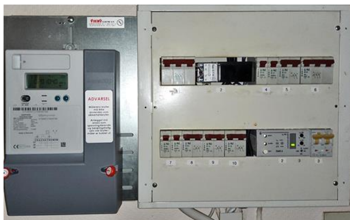
Kommentar - [Sikringsskap i gang]
