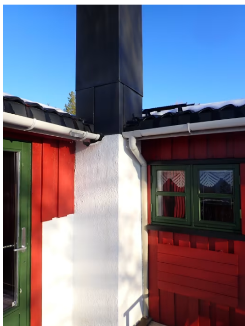
Pipe oppført utvendig.
