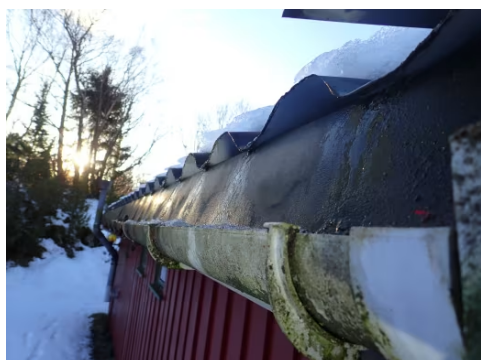
Takrenner er med stor slitasje og lekkasjer.
