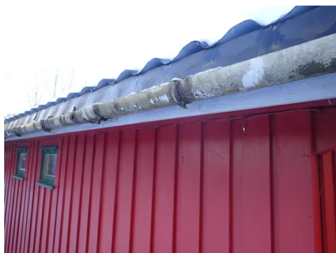
Takrenner er med stor slitasje og lekkasjer.
