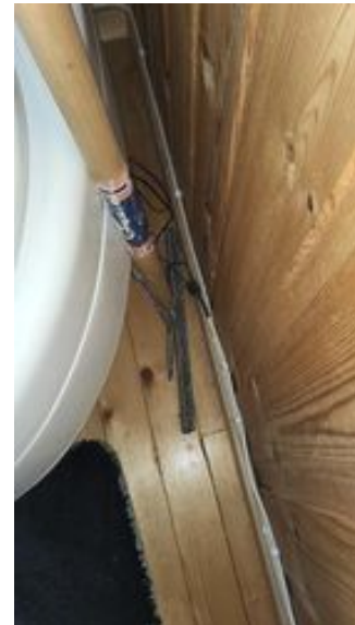
Forenklet vurdering av det elektriske anlegget - [Løse kabler toalettrom]
