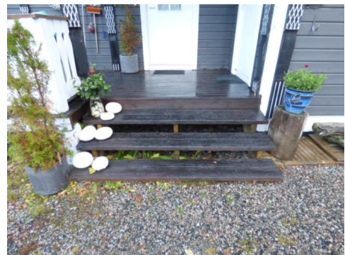
Trapp ved inngang
