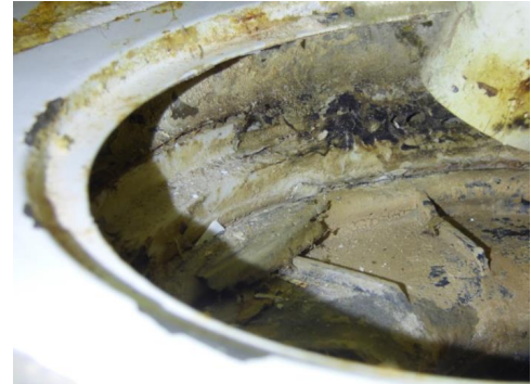
Membran sprekker opp/løsner
