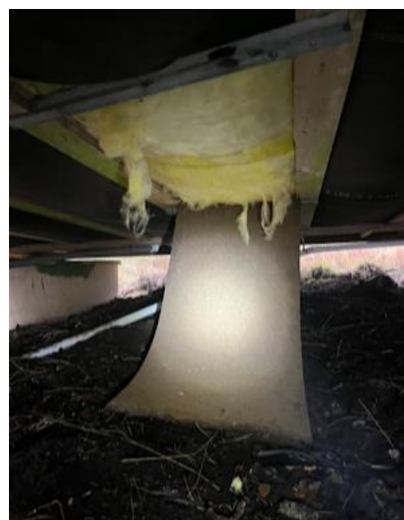
Fundamenter - [Løse stubbloftsplater.]
