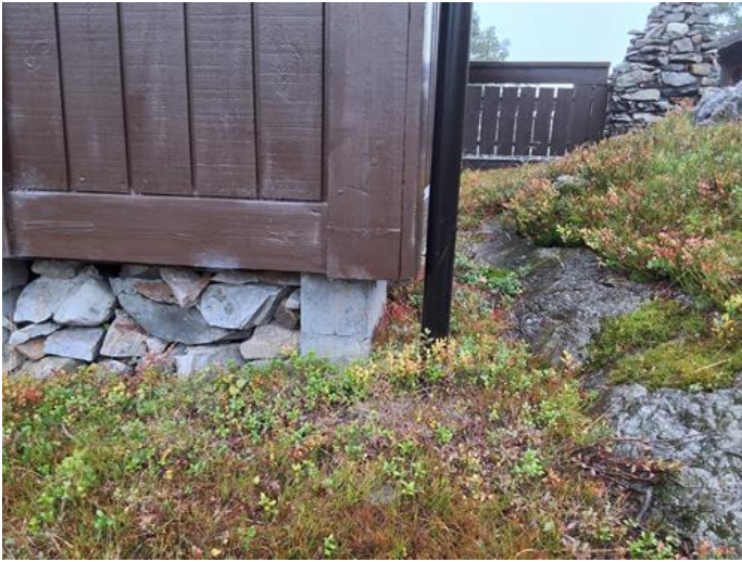
Utvendig - [Hjørne mot sør]
