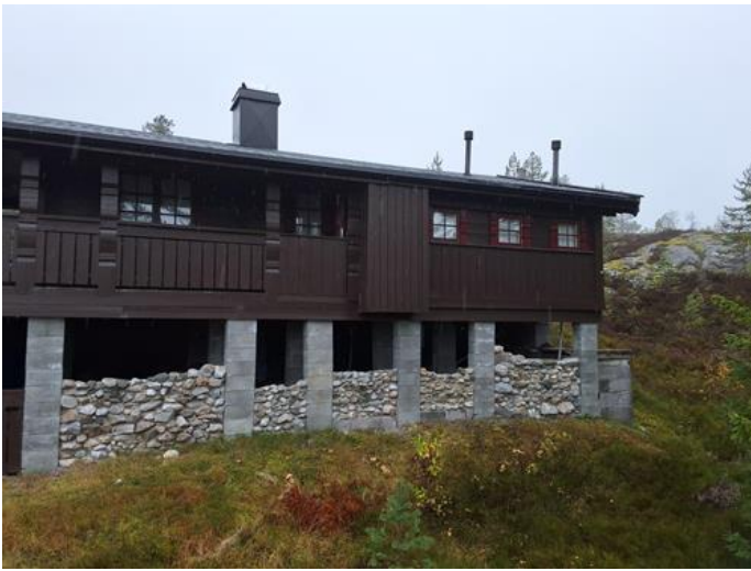
Utvendig - [Fundamenter og fasade]
