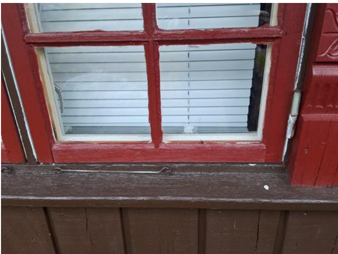
Utvendig - [Vindu på værutsatt vegg]
