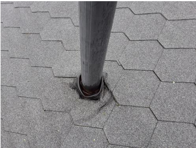
Utvendig - [Takgjennomføring, luftehatt]
