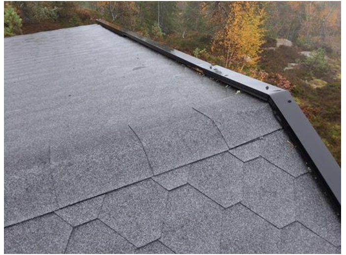
Utvendig - [Yttertak og israft beslag]
