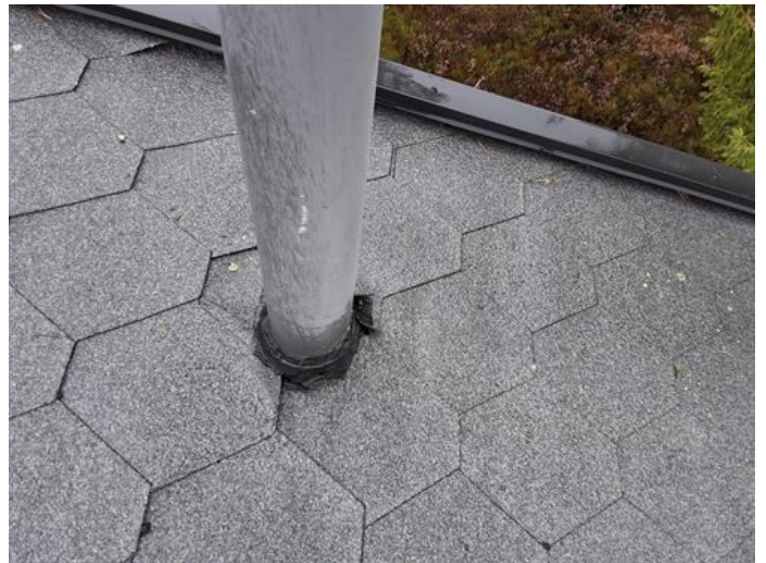
Utvendig - [Takgjennomføring, luftehatt]
