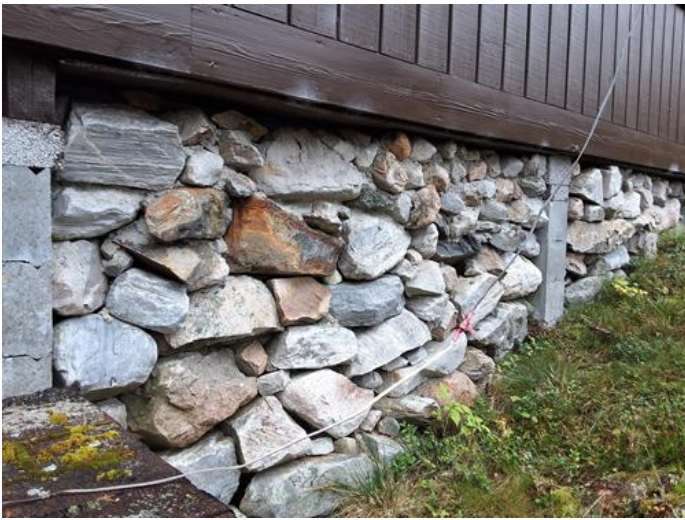
Utvendig - [Fundamenter og natursteinsmur]
