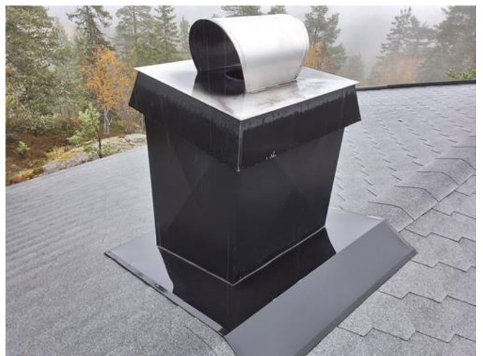
Utvendig - [Pipe over tak]
