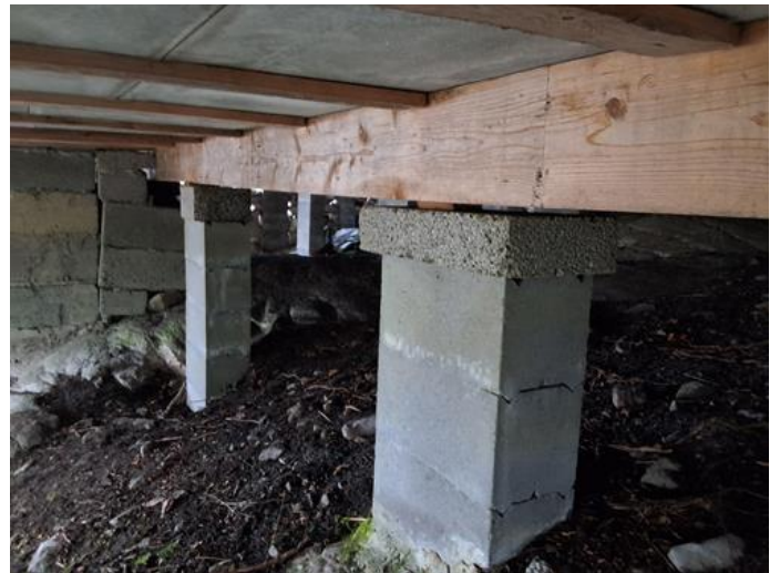
Utvendig - [Stubbloft, søylefundamenter og drager]
