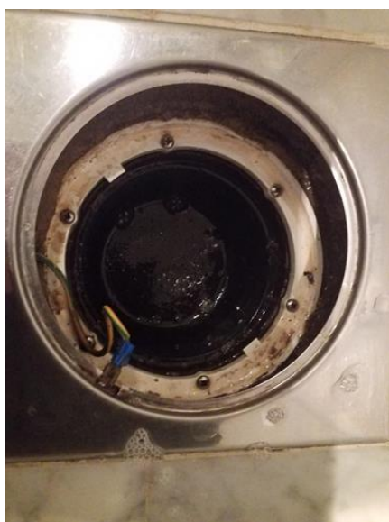
Membran, tettesjikt og overgang til sluk. - [Sluk i baderom 1.]
