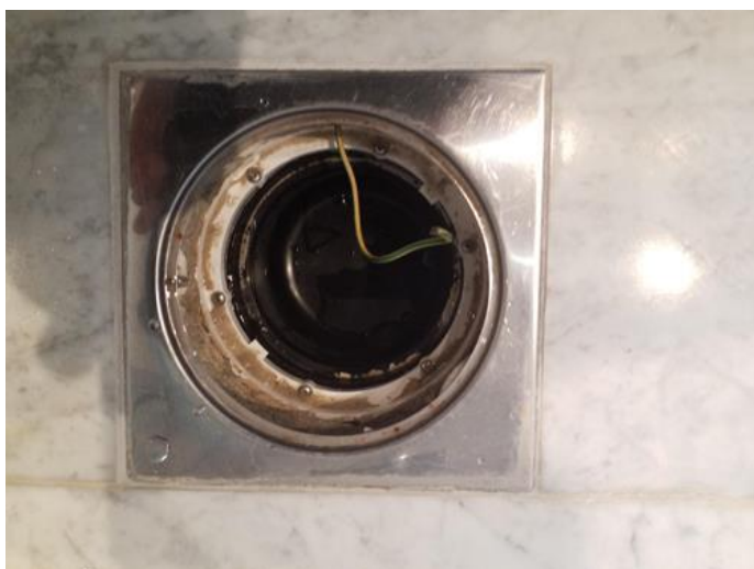
Membran, tettesjikt og overgang til sluk. - [Sluk i baderom 2.]
