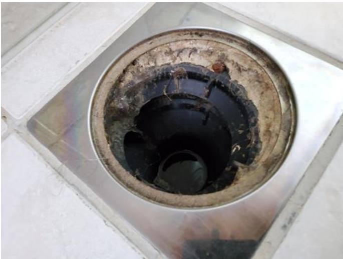
Membran, tettesjikt og overgang til sluk. - [Sluk i bad 2. etg.]
