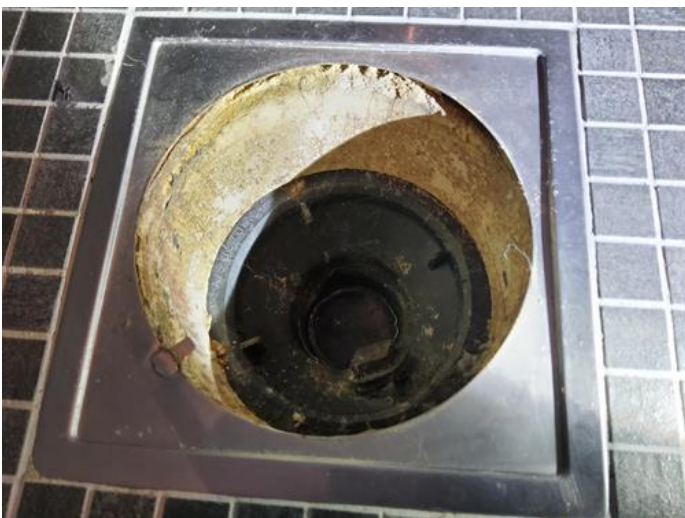
Membran, tettesjikt og overgang til sluk. - [Sluk i bad 2. etc.]
