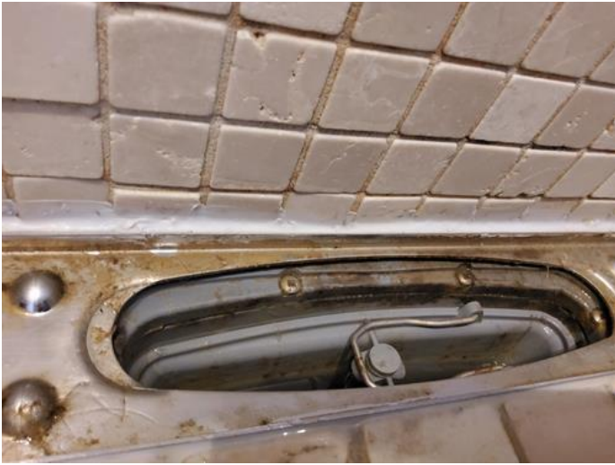
Membran, tettesjikt og overgang til sluk. - [Sluk i bad 1. etc.]
