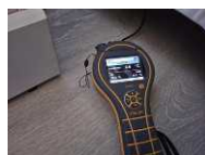
Utført kontroll i tiliggende konstruksjon - Fuktmåling bad.
