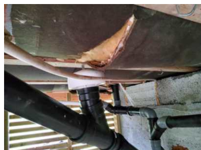
Andre forhold. (som ikke inngår i det foran) - [Utettheter i stubbeløft.]
