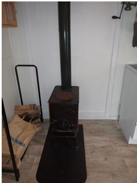
Vedovn på kjøkken.
