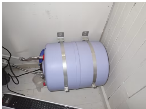
Varmvannsbereder.
