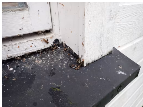
Beslagsløsninger uten dryppkant på treverk.
