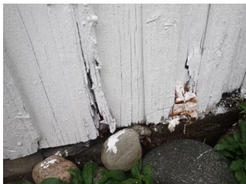
Råte i kledning inn mot gårdsplass.
