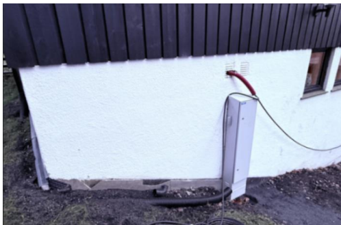
Utløp fra drensrør nær grunnmuren.
