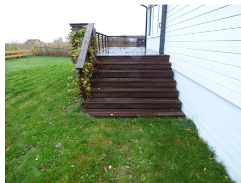
Trapp til veranda
