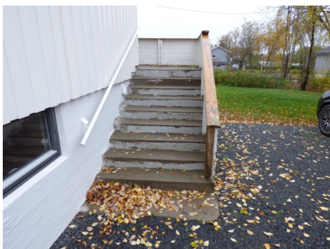
Trapp ved inngang
