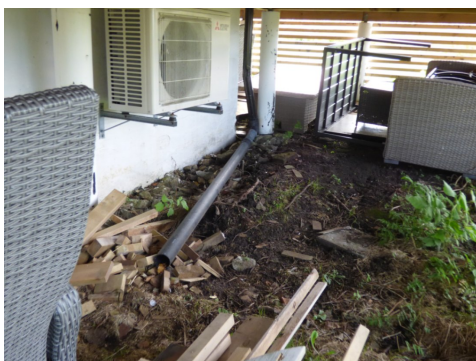
Bortledning av vann fra hjørne mot sørvest
