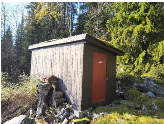
Utvendig - [Frittliggende bod]
