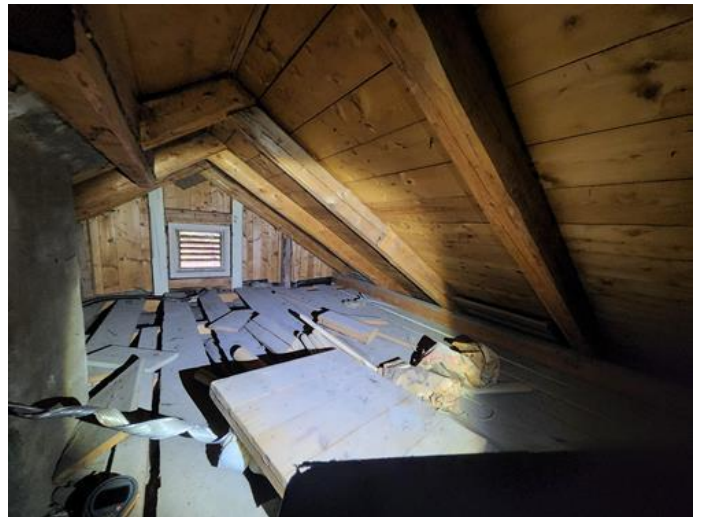
Loft - uinnredet / råloft - [Loft over tilbygget del mot nord. ]
