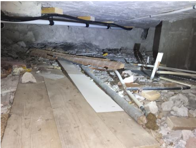
Innvendig inspeksjon - [Krypekjeller. ]
