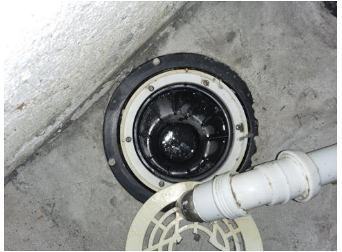
Rom under terreng (kjeller, underetasje, sokkeletasje) - [Sluk i kjeller i hovedenhet. ]
