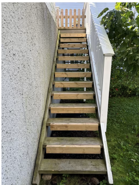
Trapp til hage i 2. etg er en åpen tretrapp i impregnert trevirke.
