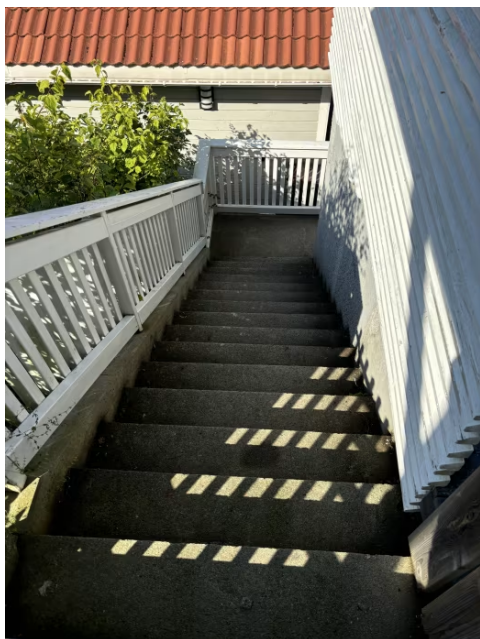
Trapp fra garasjen til boligen er i betong og med rekkverk i malt tre.
