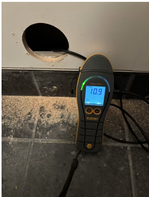
Hulltaking med fuktmåling uten avvik, målt vegg på vaskerom mot yttervegg under terreng.
