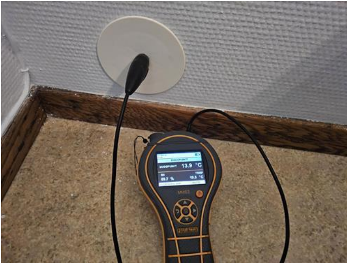
Rom under terreng (kjeller, underetasje, sokkeetasje) - [Fuktmåling]
