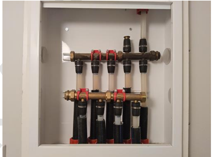
Vannrør (Sjekkpunkter utover det som er inkludert i andre rom) - [Fordelerskap for rør-i-rør system]
