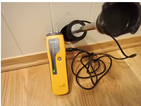
Hulltaking og fuktsøk, ingen skader eller fukt oppdaget i konstruksjonen.
