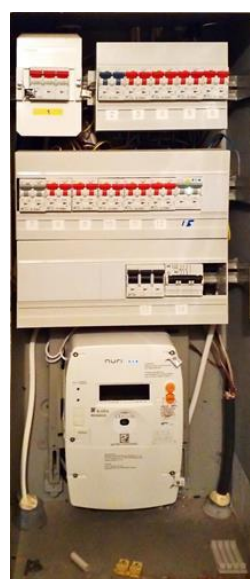
Forenklet vurdering av det elektriske anlegget - [Sikringsskap utleie]
