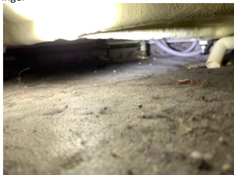
Sluk under dusjkabinett
