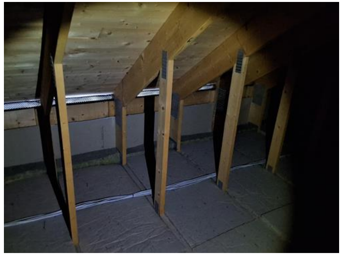
Loft - uinnredet / råloft - [Loft, lufting ved raftelinje mellom sperrer.]
