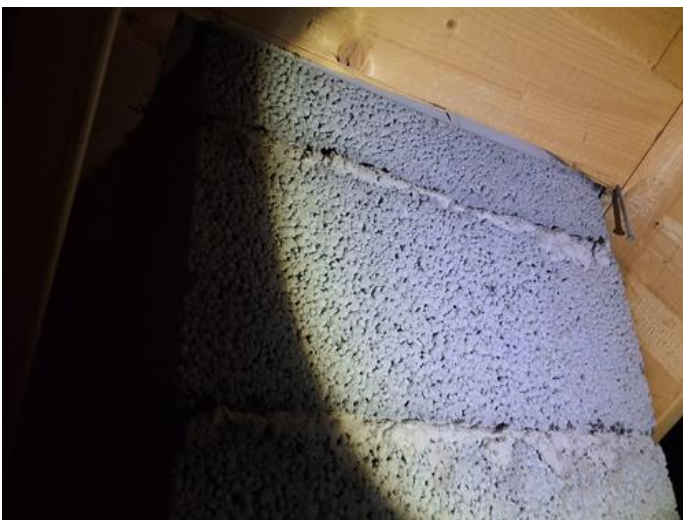
Loft - uinnredet / råloft - [Pipe på loft]
