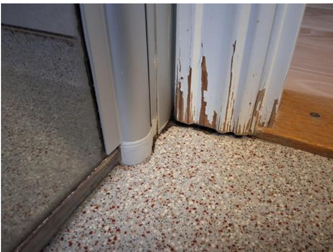
Våtrom - [Overgang dusjvegg og terskel ]
