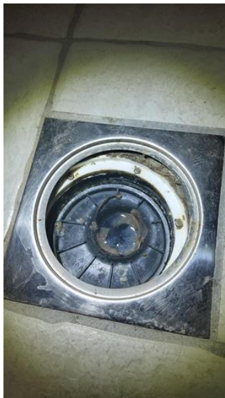
Våtrom - [sluk bad 1. etasje]
