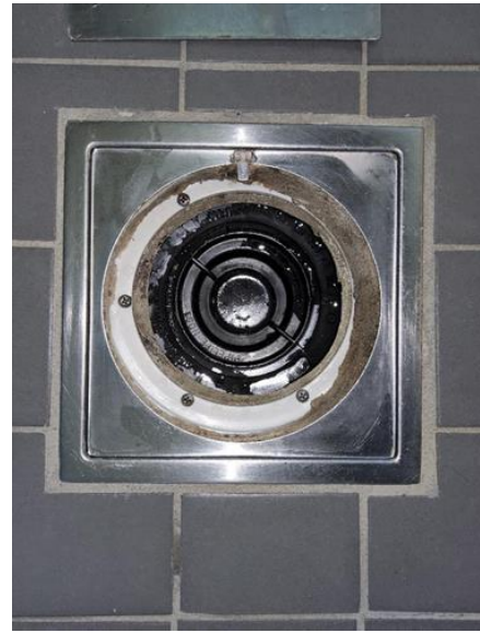
Avløpsrør (ink. sluk) - [Sluk dusjsonen bad hoveddel]
