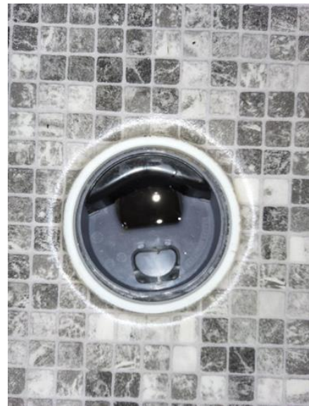
Avløpsrør (ink. sluk) - [Sluk vaskerom hoveddel]
