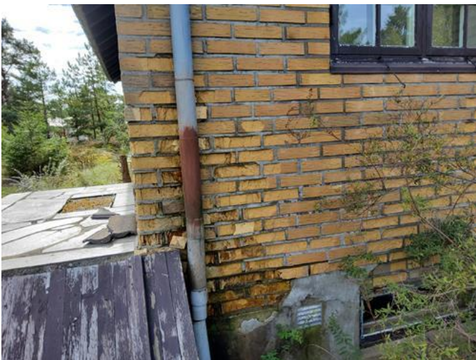
Yttervegger inkl. fasader og konstruksjon - [Yttervegg mot nordøst.]
