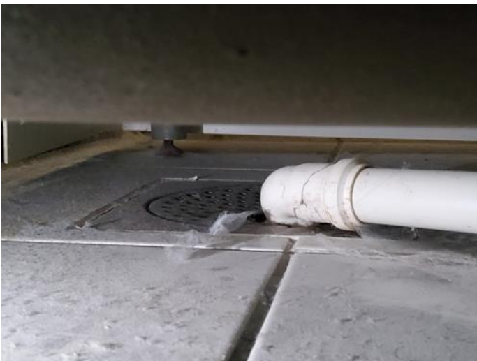
Kommentar - [Sluk under dusjkabinett i bad i underetasje.]
