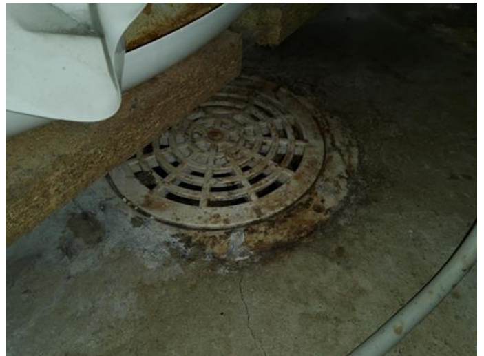
Kommentar - [Sluk i bod i underetasje.]
