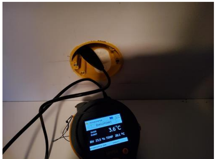
Kommentar - [Fuktmåling bad i loftsetasje. ]
