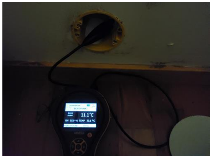
Kommentar - [Fuktmåling bad underetasje fra kjøkken.]
