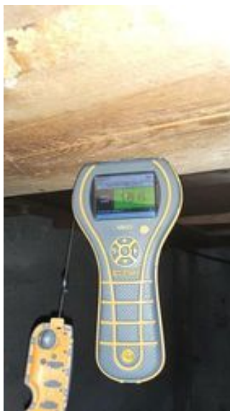
Innvendig inspeksjon - [Fuktmåling i kyrpkjeller]
