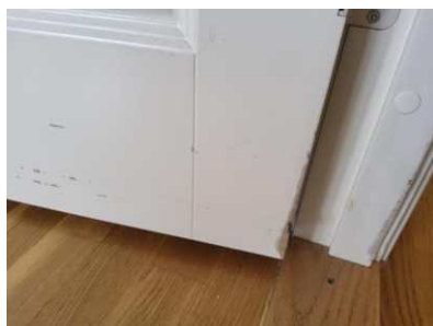
Kommentar - [Skade innerdør og karm]
