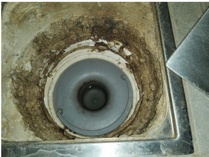
Membran, tettesjikt og overgang til sluk. - [Sluk baderom 2.etasje ]
