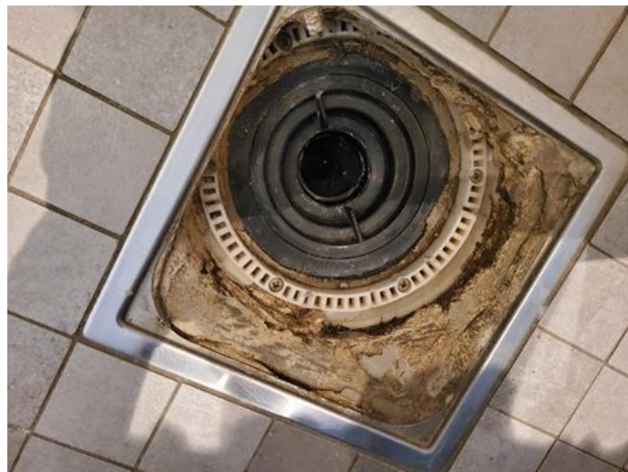
Membran, tettesjikt og overgang til sluk. - [Sluk baderom underetasje ]
