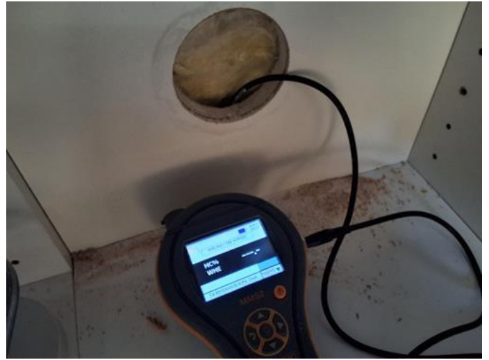
Våtrom - [Fuktmåling bad 1.etg]
