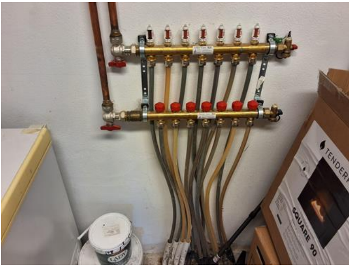
Tekniske anlegg, VVS anlegg (Sjekkpunkter utover det som er inkludert i andre rom) - [Samlestokk for vannbåren varme 1]
