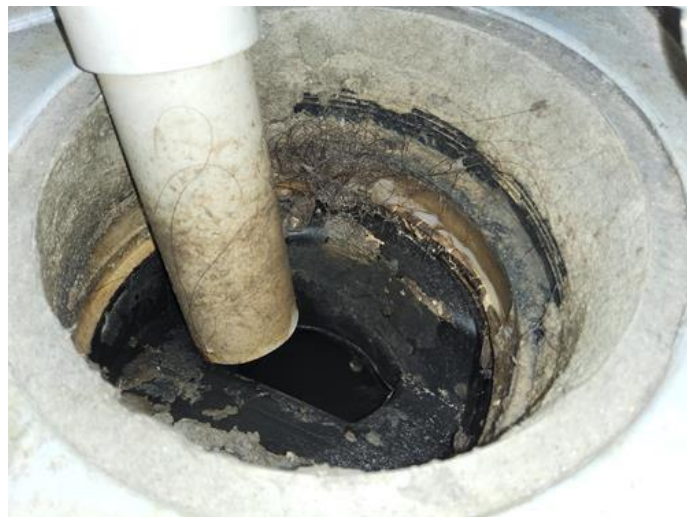
Membran, tettesjikt og overgang til sluk. - [Sluk bad 2.]
