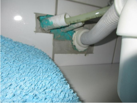
Rørgjennomføringer i vegg.
