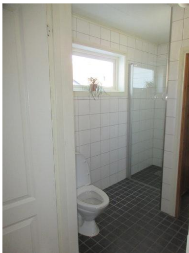
Fliser på gulv og vegg, WC, dusjnische
