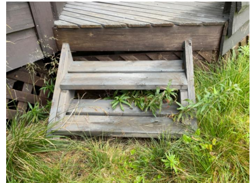
Trapp til terrasse i kjelleretasje
