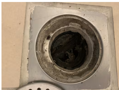
Sluk plassert på baderomsgulv.
