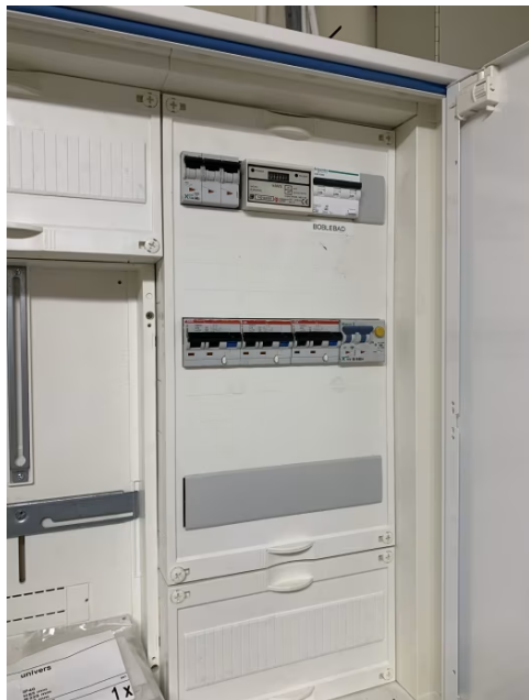
Separat sikringskap for hybel (oppvarming av uteboblebad inngår).
