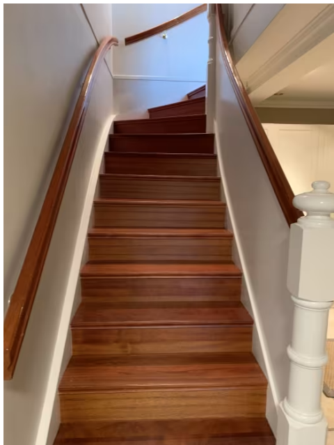
Innvendig trapp til 1. etg er en lukket tretrapp.
