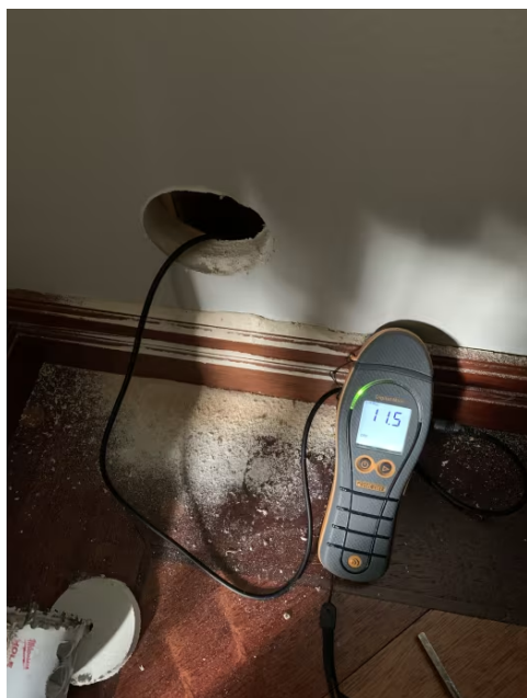
Hulltaking med fuktmåling fra tiliggende omkleddingsrom uten avvik.
