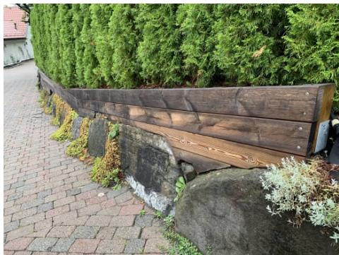
Støttemur i naturstein og impregnerert gjerde langs innkjørselen.
