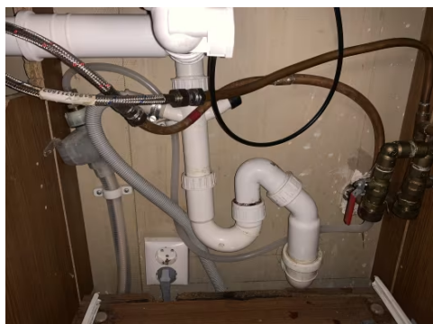
Avløpsrør i underskap vask på kjøkkenet.
